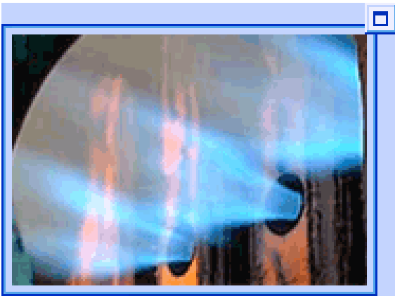
Рис.3 Фотография общего вида факела новой горелки в топке котла.
