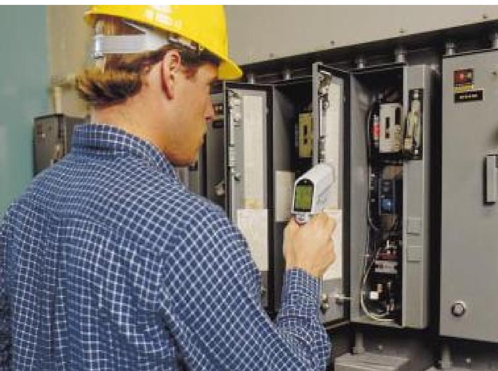
Инфракрасные термометры – приборы, необходимые для диагностики и контроля электрических систем и оборудования. Применяемые для работы с электрооборудованием более 30 лет, неконтактные термометры позволяют быстро производить измерения температуры.
