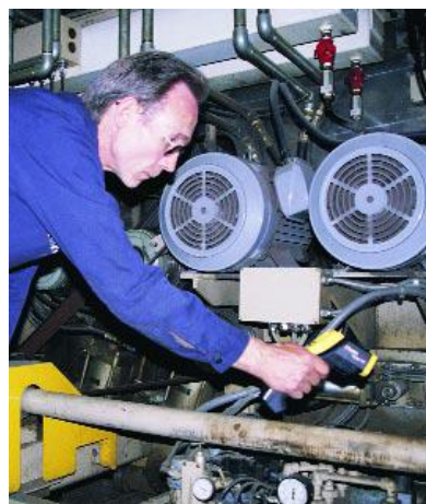
Контроль линейного оборудования Проверка движущихся деталей на предмет износа и смазки.
